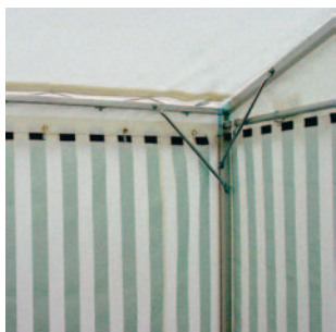
Saubere Planenspannung durch Expanderseile – die Seitenplanen werden am Dachplanenvolant eingehängt
