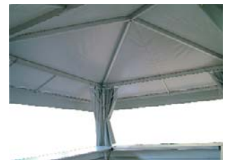
Innenansicht mit Pavillondach
