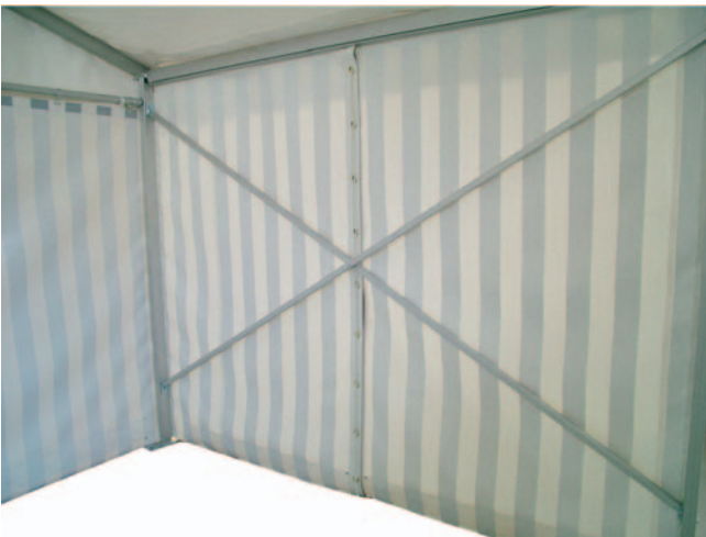
Kreuzverbände im ersten und letzten Feld für höchste Stand-Sicherheit
