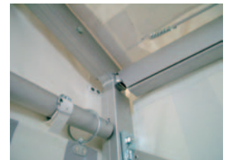
Die Traufecke im Stecksystem
