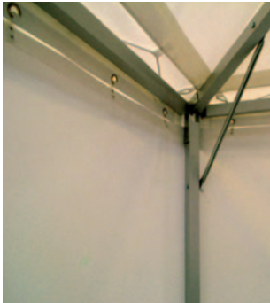
Befestigung der Seitenplanen mittels Kunststoffhaken in der Dachplane
